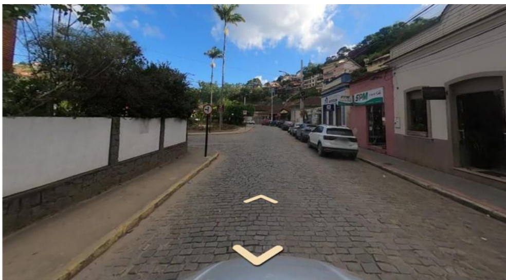
Figura 4 - Pavimentação em Bloco Paralelepípedo na Avenida Getúlio Vargas
