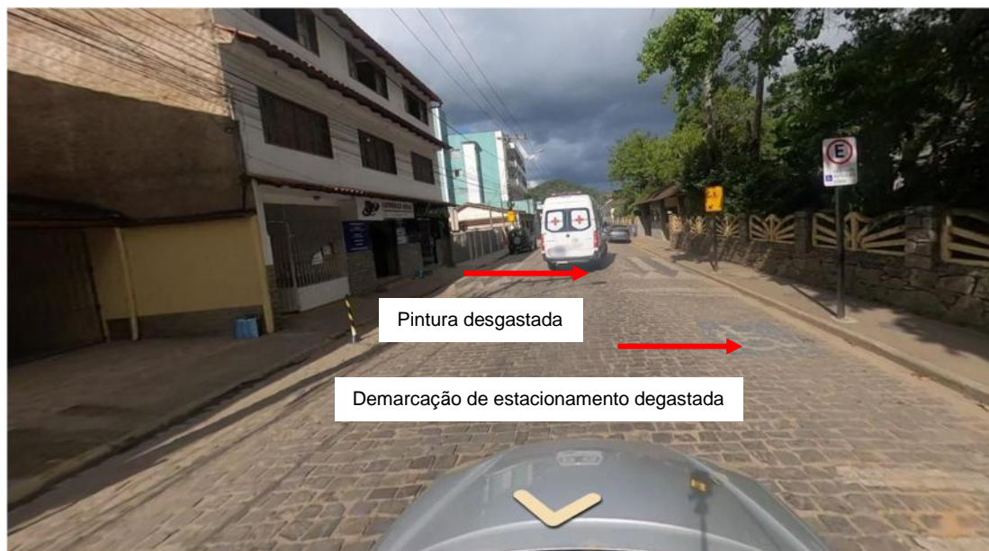
Figura 44 - Sinalização desgastada na Avenida José Ruschi.
