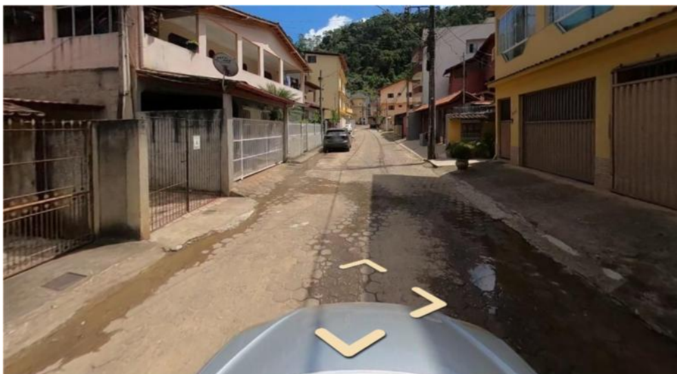
Figura 5 - Pavimentação em Bloco na R. Luiz Duarte Machado da Silva
