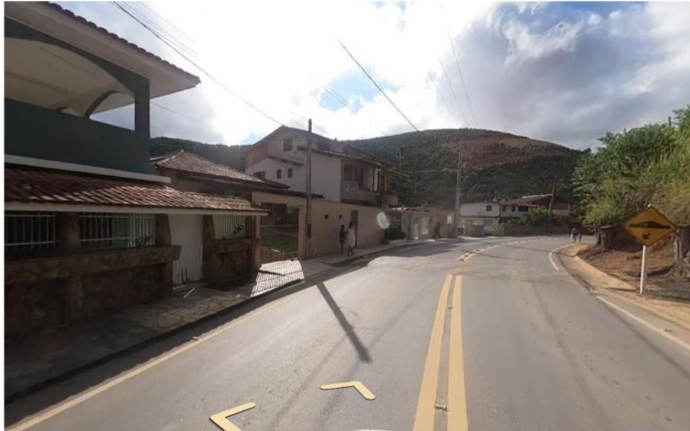
Figura 34 - Vista da Rodovia ES-261 no distrito de Alto Caldeirão
