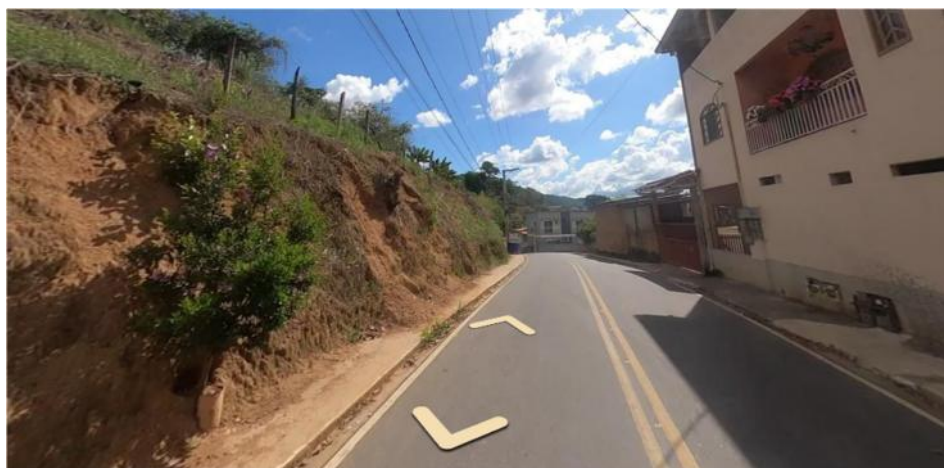
Figura 2 - Pavimentação Asfáltica na R. Hilário Passolini
